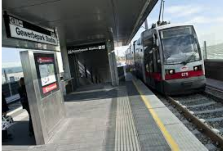
Straßenbahnlinie 26 beim Gewerbepark Stadlau, Quelle Wiener Linien
