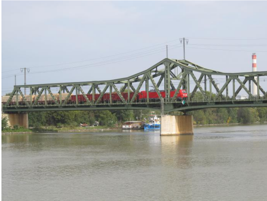
Stadlauer Eisenbahnbrücke, Quelle: Wikimapia
